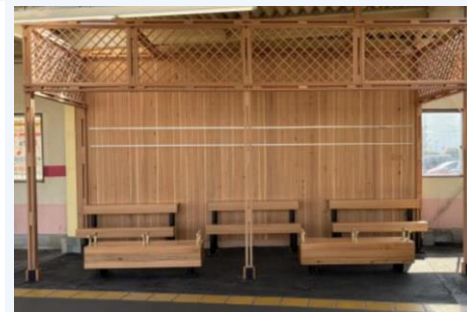
〈二和向台駅〉 千葉県産木材を使用した待合スペースと 太陽光発電・再生電力吸収装置を設置
